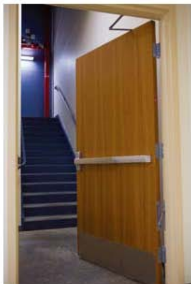
楼梯间门、外围疏散门设计时，应考虑逃生、人员疏散、防火等紧急功能要求
